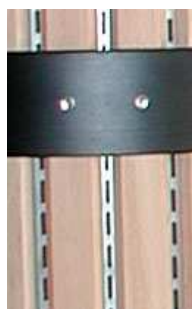
Foto 3, Schlitzbleche als einzige Öffnungen für den Saftablauf.
